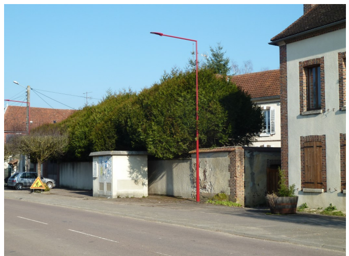
Travaux Grande Rue
