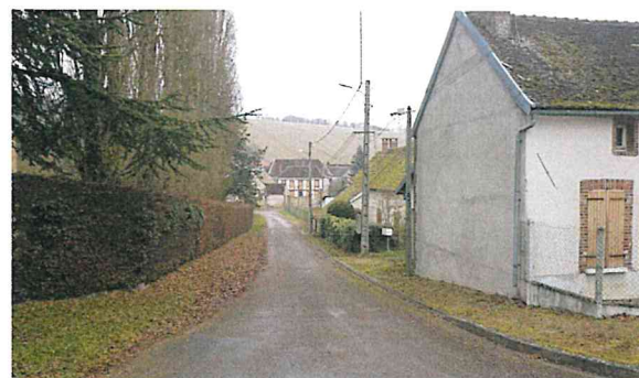
Fenêtre sur l'espace agricole à Vaudevanne
